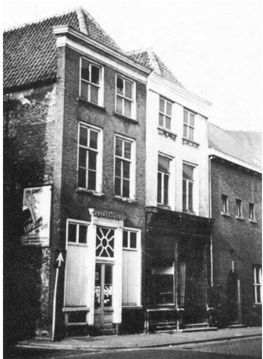
Afb 22 De voorgevels vóór de restauratie. Onder het rechtse zolderraam van de Draeck is de gevelsteen (Afb. 16) zichtbaar.
