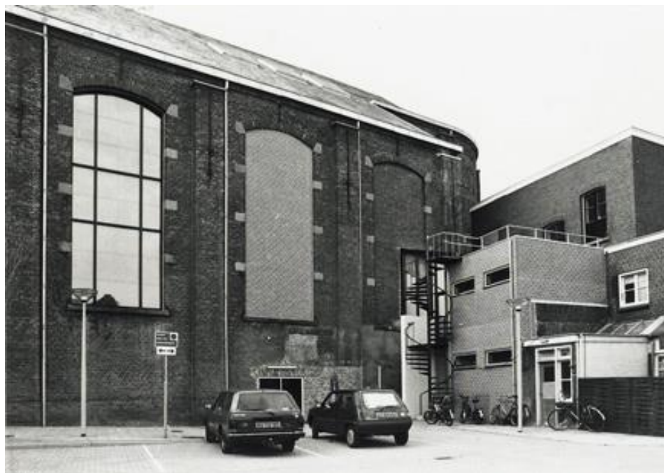
49. De noordelijke zijgevel van de Stadsschouwburg 'De Maagd', 1990.
