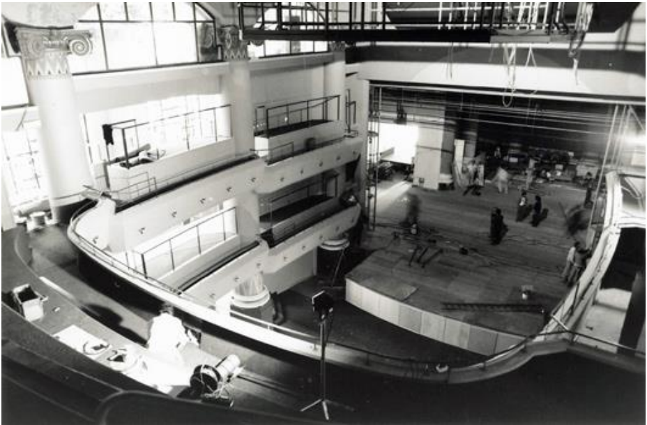
68. De theaterzaal, gezien vanaf het tweede balkon op de bovenste rij (bij de deur naar de Kapitelenzaal), 1990. Opname tijdens de eindfase van de bouwwerkzaamheden
