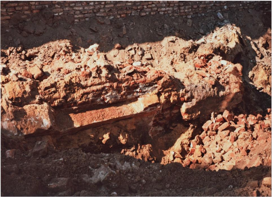
afb. 25. De noordelijke muur van de kapel, waarin de aanzet van een keldergewelf was ingemetseld.
