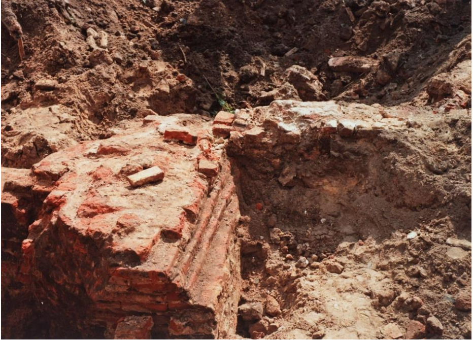
afb. 26. Zuidelijke steunkolom, links de muur van het koorgedeelte, rechts achter de muur van het schipgedeelte.
