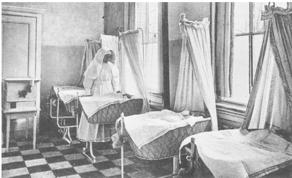
Afb. 35. De zogenaamde wiegkamer in het ziekenhuis (omstreeks 1928).
