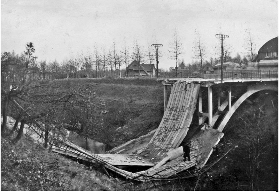
De verwoeste Zoombrug tussen Zandstraat en de Van Overstratenlaan WBA RTWV105
