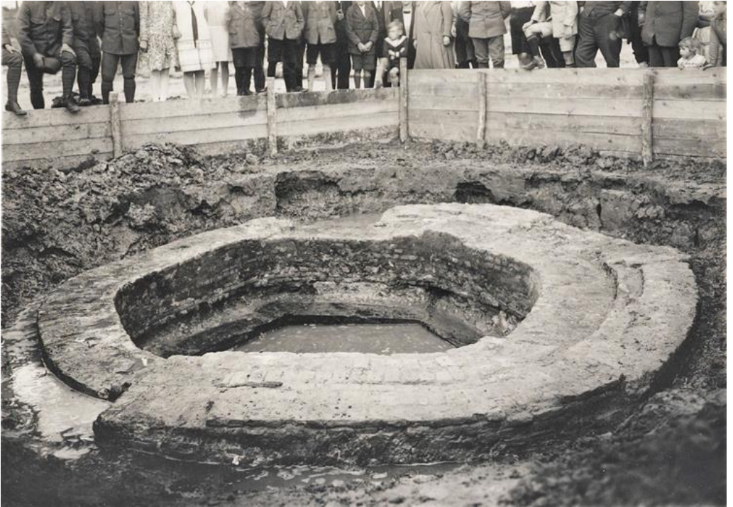
De fundamenteën van de Gertrudisbron in 1929 WBA SCHE132
