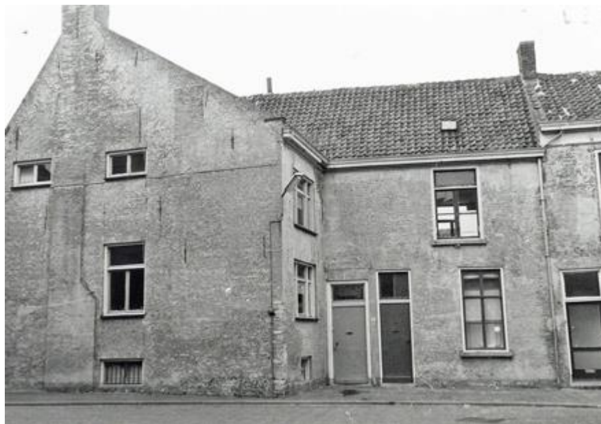
Afb 22. Straatgevels van het kernhuis en de dwarsvleugel vóór de restauratie. (WBA SGOU033 )
