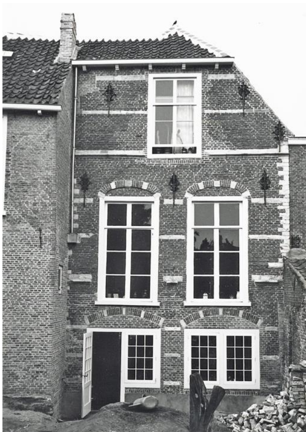
Afb. 25 Achtergevel van het kernhuis na de restauratie, 1978. (WBA SGOU041 )
