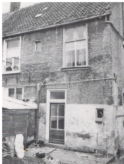
Afb 32. Achtergevel van de dwarsvleugel vóór de restauratie. WBA SGOU034
