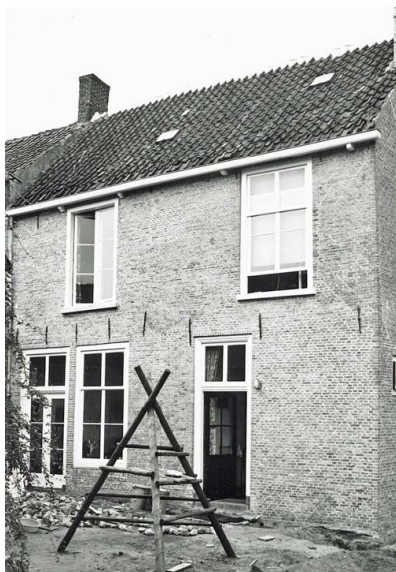
Afb 33. Achtergevel van de dwarsvleugel na de restauratie, 1978. WBA SGOU038
