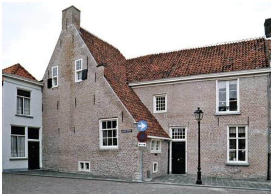
Afb. 23. Straatgevel van het kernhuis na de restauratie, 1973.
