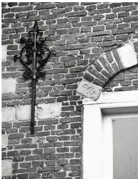
Afb 29. Detail van de achtergevel met sieranker en sluitblokje.
