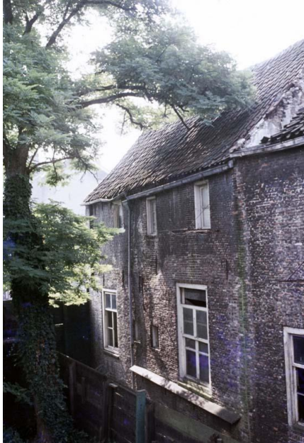
25. Achtergevels aan het binnenterrein van de huizen aan de Sint Annastraat (Gevels van de panden Sint Annastraat 14, 16 en 18. (Foto J. W., 1974).
