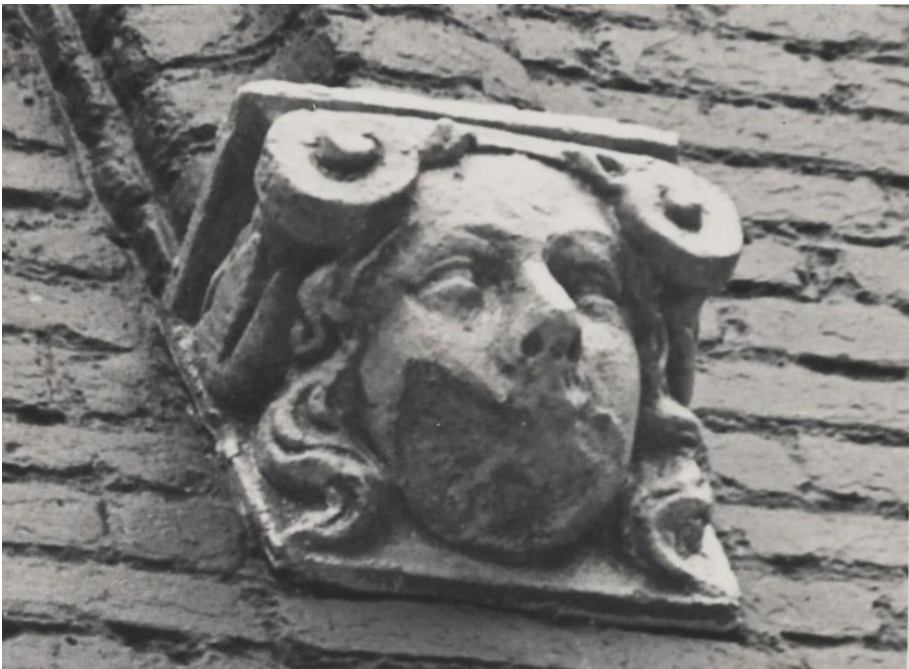
24-25. Kragsteen met ionische kapitelen en beeldhouwde kopjes in de voorgevel van het huis Oostenrijk.
