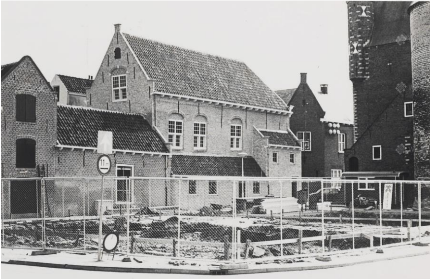
28 De westgevels na restauratie
