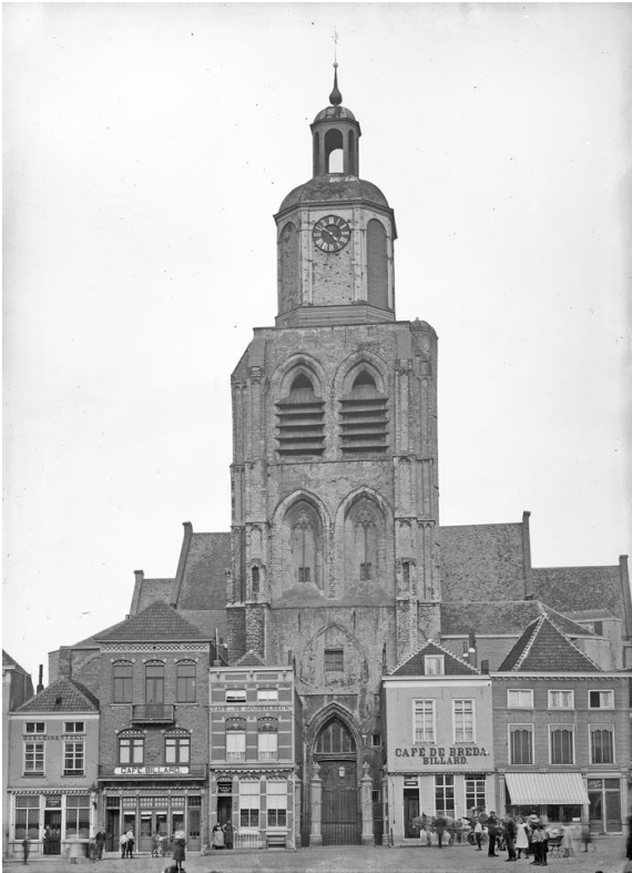
Afb 29 De toren van de Markt gezien. RCE De openingen in de opbouw zijn met stenen dichtgemetseld
