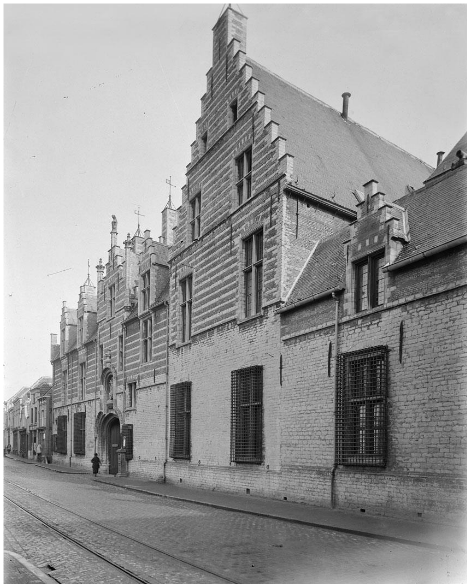
Afb 41 Voorgevel van het Markiezenhoef (sec)
