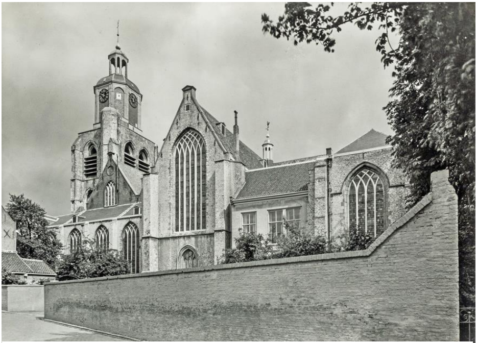
Afb 28. Grote of Ste Geertruikerkerk, zuidgevel met transept. RCE
