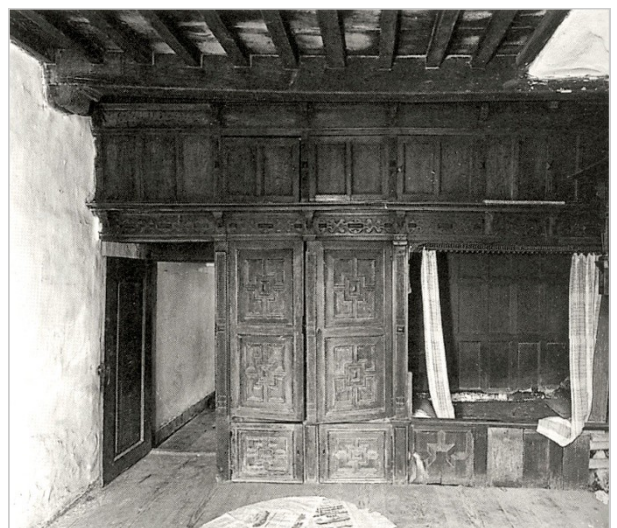
15de eeuw opgeklampte deur; deur met briefpanelen; wand uit de 17de eeuw met kast en bedstede
