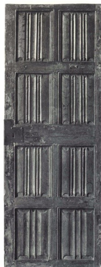
15de eeuw opgeklampte deur; deur met briefpanelen; wand uit de 17de eeuw met kast en bedstede
