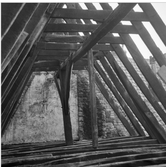
sporenkap met lengteverband, Bergschild 14 Deventer
