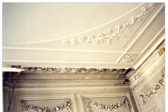
stucplafond rond 1800, Zuivelplein 6
