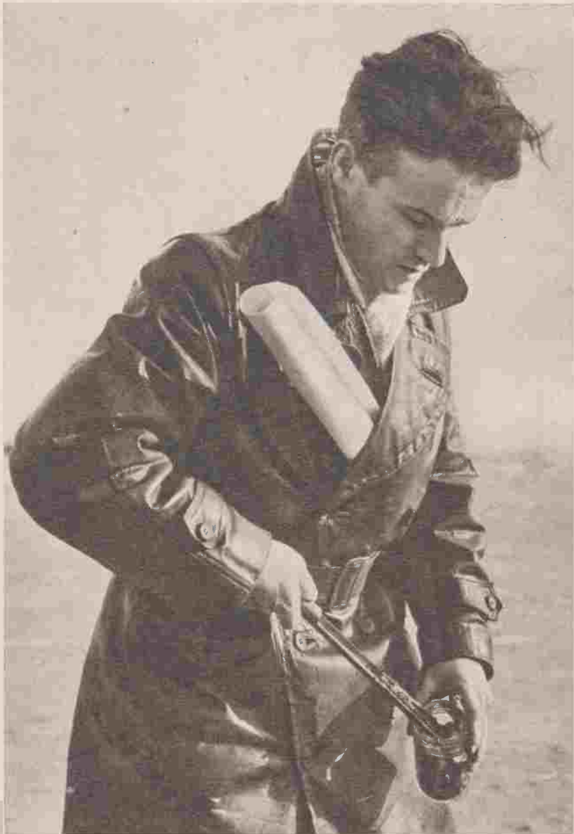
In een flesje wordt wat van de grond meegenomen. Het flesje wordt luchtdicht afgesloten om verdamping van het water tegen te gaan en daarna wordt op een stafkaart precies aangetekend waar dit monster is getrokken.
