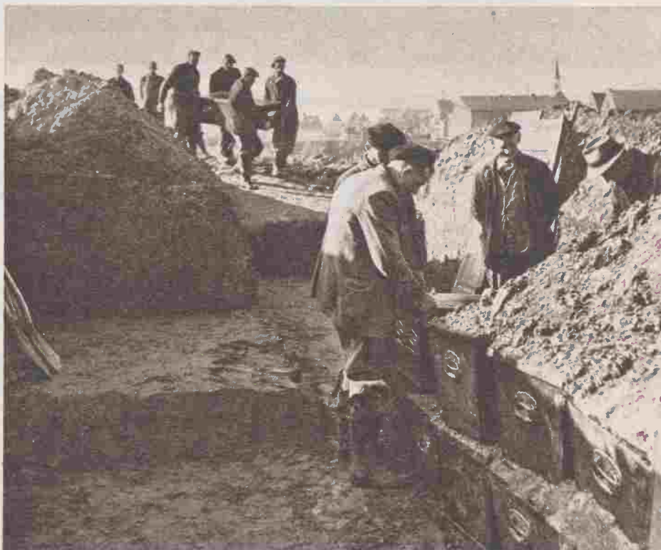
Toen de dijk doorbrak, werd hun leven genomen. Nu is de dijk hun laatste rustplaats.
