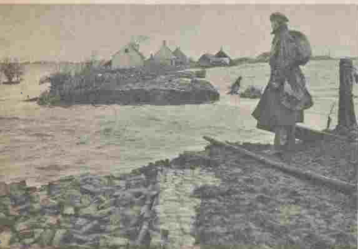
Even verder het Westbrabantse land in ligt Lepelstraat. Van land is hier weinig meer te bekennen. De dijk was hier niet bestand tegen het door storm en springvloed opgezweepte water.
