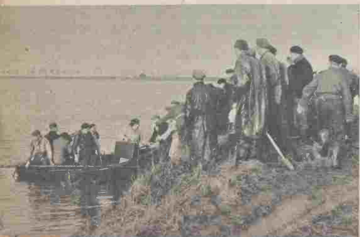
Slachtoffers uit Nieuw-Vossemeer worden in roeibootjes naar veiliger oorden overgebracht. Direct worden helpende handen uitgestoken.
