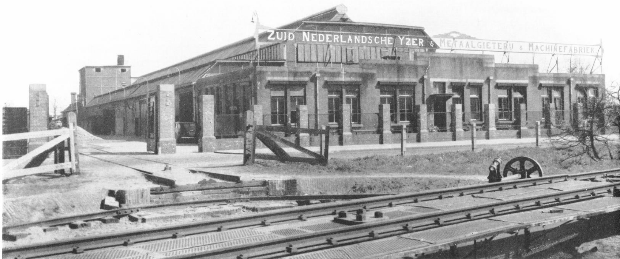
VOORGEVEL DER GIETERIJ AAN DE PARALLELWEG
