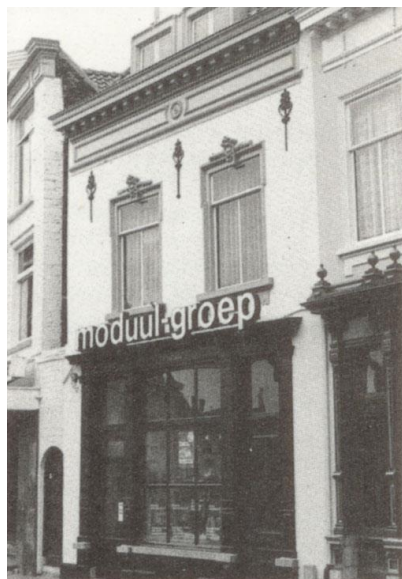
26. Grote Markt 20. Bepleisterde 17 e eeuwse gevel met nog zichtbaar de sierankers. (zie ook anno 1999 )
