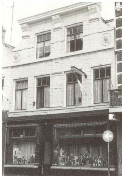
27. Zuivelstraat 33. Pilastergevel, 17 e eeuw, herkenbaar aan de gepleisterde pilasters met geverfde kapitelen.
