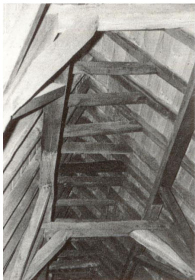
34. Potterstraat 22. Detail van de 15 e eeuwse kap; daksporen met haanhouten.
