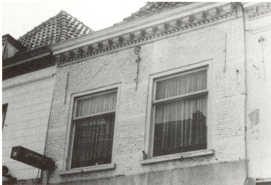
30. Bosstraat 30. Geverfde 17 e eeuwse bakstenen gevel met natuurstenen speklagen en sieranker. ( zie ook anno 1998 )
