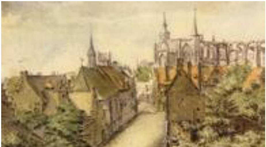
Huijbergsestraat met links de kapel van het Cellenzusterklooster (detail tekening door Bernardus Klotz, 1671)
