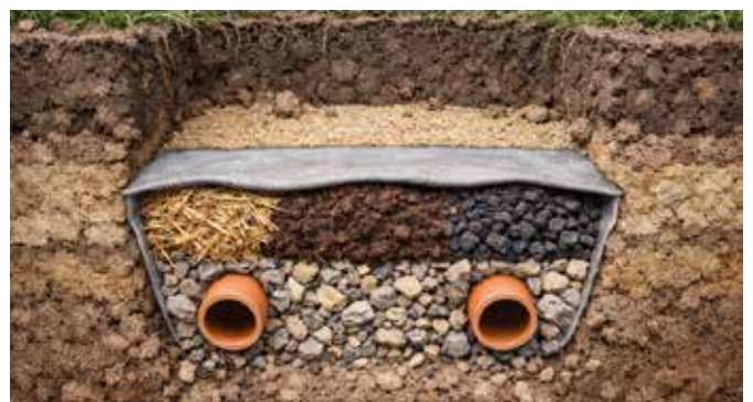
Doorsnede drainagesleuf
